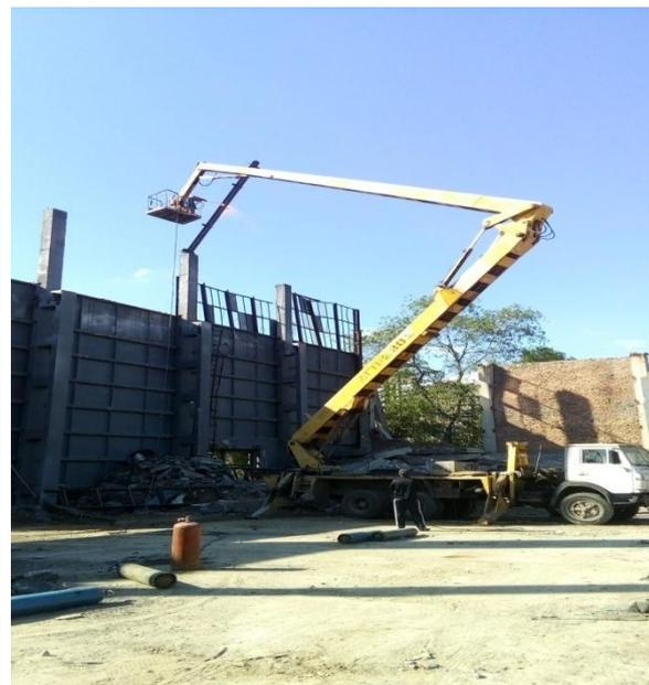
**Демонтаж крыши из металлических ферм и ЖБИ плит, на территории завода Фосфор
