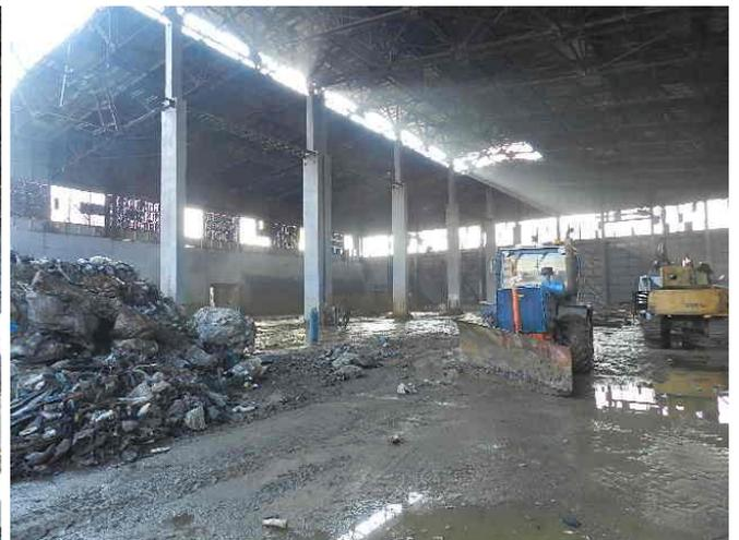
**Демонтаж крыши из металлических ферм и ЖБИ плит, на территории завода Фосфор
